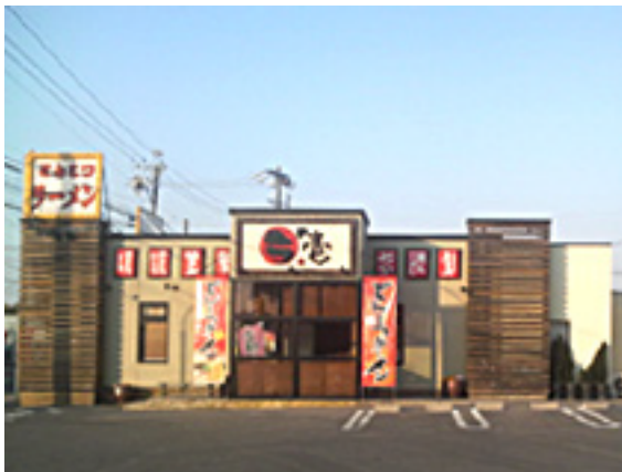
【店舗屋根折板施工】
